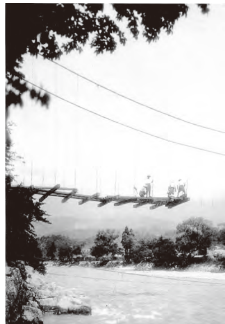
万年橋の架設作業を行うとび職の職人たち
